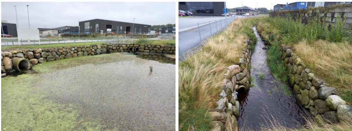
Figur 5.3. Overvann fra industriområdet på Bø går inn i fordrøyningsdam (øverst t.v.) eller direkte ut i bekkeløpet (t.h.).
