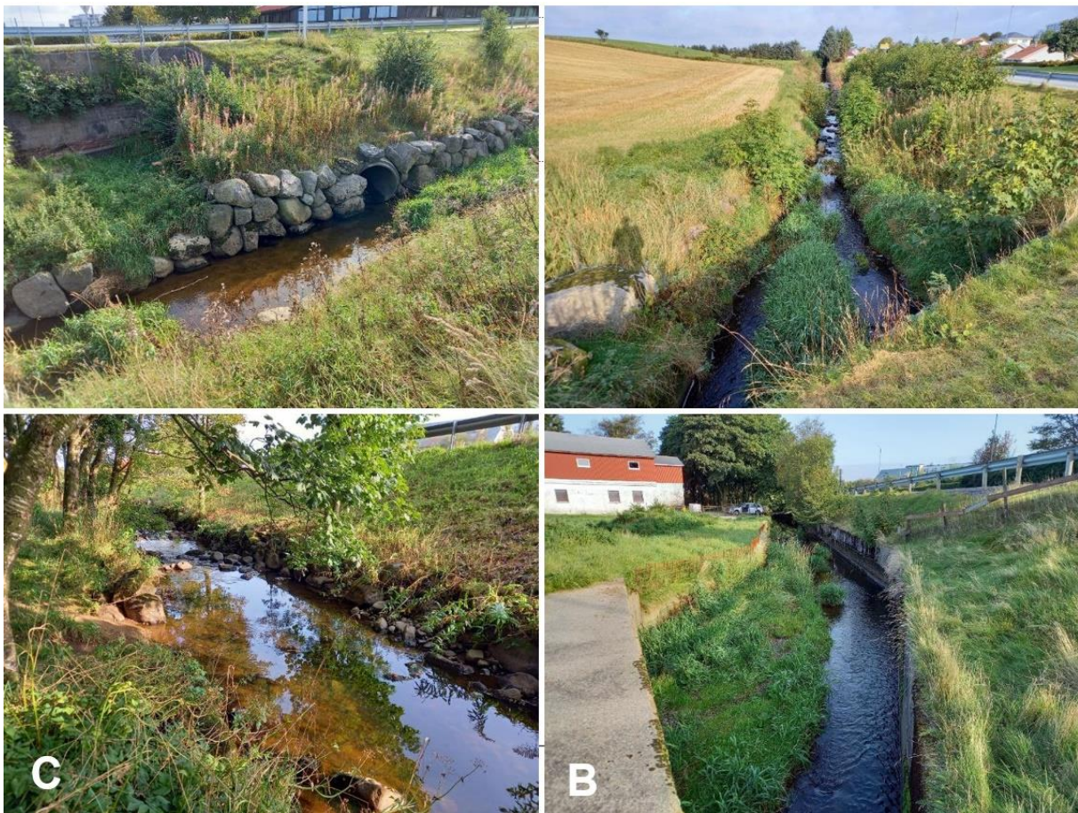
Figur 4.3. Bekkeløpet langs Store Ring. C viser til et mer naturtypiske strekk oppstrøms Skjerpevegen, og B til ansamlet mudderbak i betongsatt kanal. Fjern bokstaver
