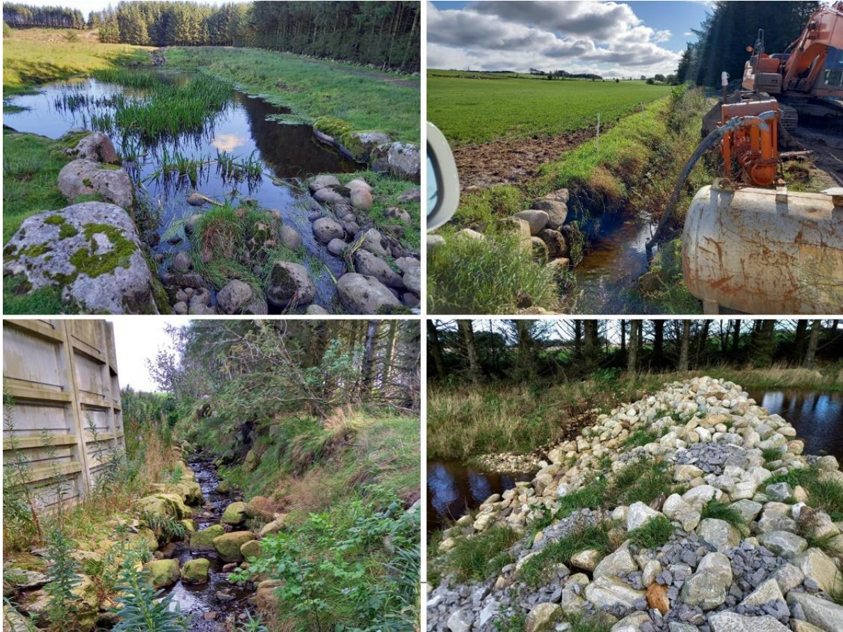
Figur 4.9. Renseparken i nedre del av D1.2.1 (øverst t.v.), åpen kanal i D.1.2.2 (øverst t.v.), og bekkeløp opp til rensepark med punktert permeabel terskel på Opstad, D2 (nederst).
